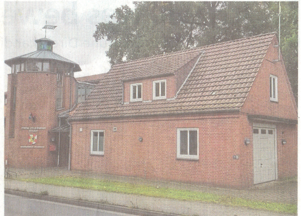
Heiligenrode soll nach der Verlagerung des Feuerwehrhauses Hygienezentrum für die Gemeindefeuerwehr werden.
