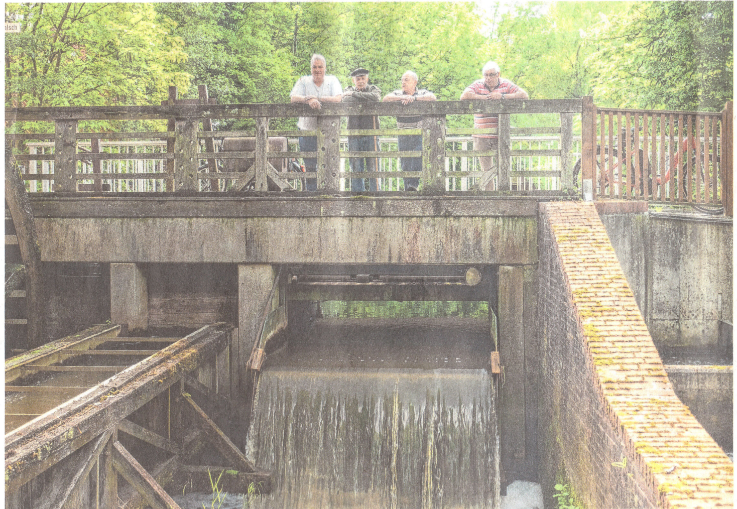
Blicken auf die wieder funktionierende Wasserregulierung am Mühlenwehr und den nun schlammigen Klosterbach (v. l.): Henning Rogge, Cord Hildebrand, Rainer Woiwode und Wilfried Cassens. FOTO: VASIL DINEV
