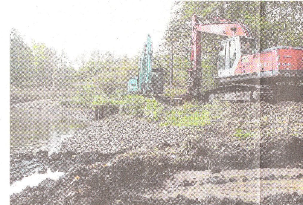
Schweres Gerät: Zunächst wird eine Stahlbrücke und eine Straße aus Stahlplatten in den Mühlenteich verlegt, damit die Maschinen darauf fahren können. FOTOS: GREGOR HÜHNE
