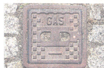
Unter der Metallplatte im Fußweg befindet sich eine Absperrvorrichtung für eine Gasleitung.
