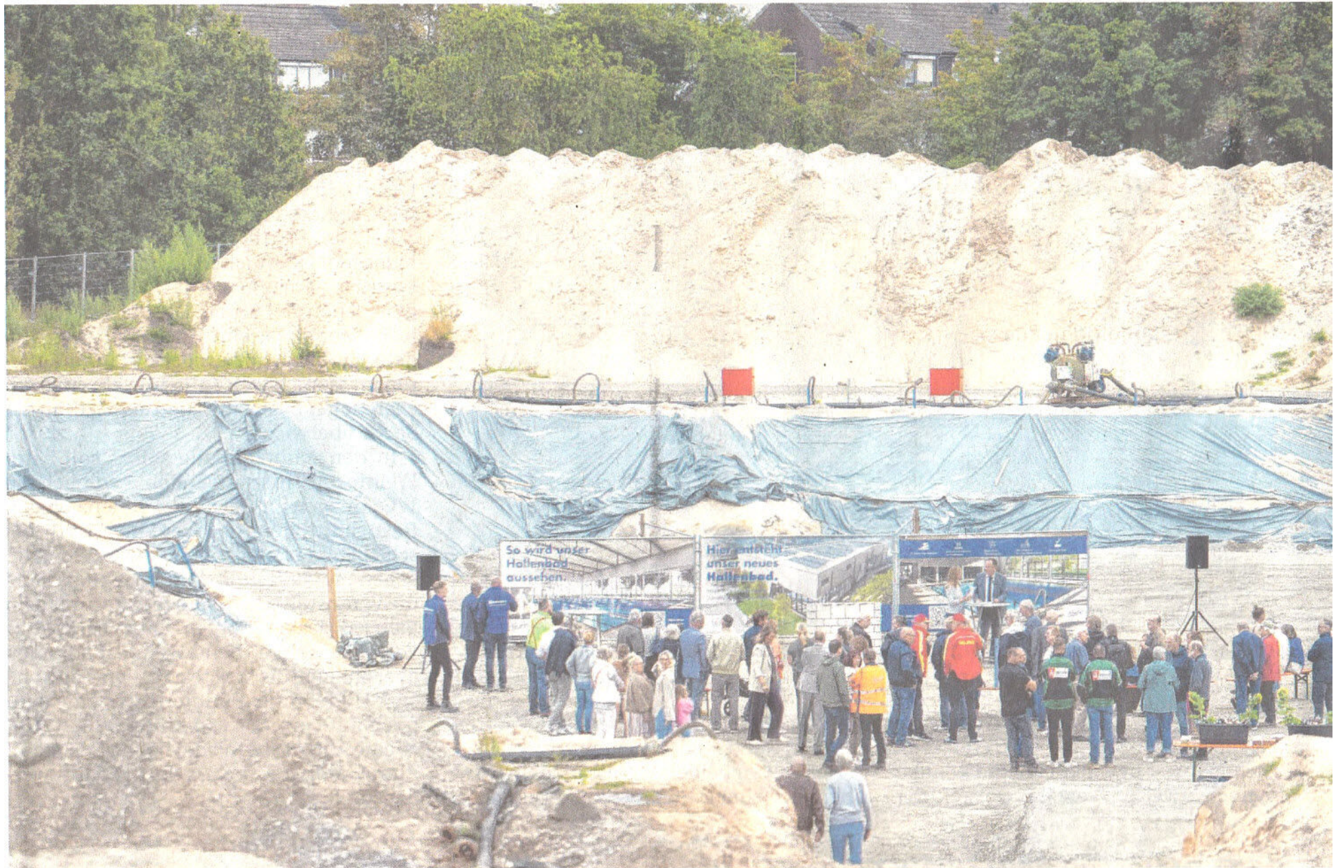
Vertreter aus Politik und Gesellschaft versammelten sich zur Grundsteinlegung für das Hallenbad in Brinkum.
