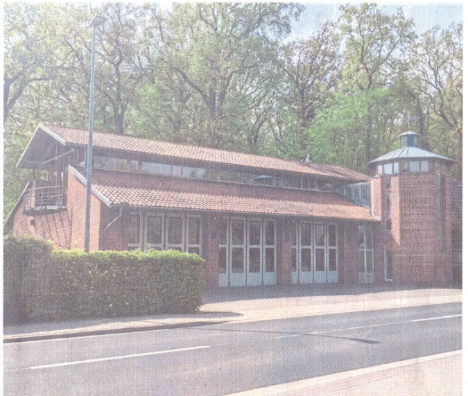
Keine Erweiterungsmöglichkeiten, gefährliche Anbindung: Am Standort Heiligenroder Straße kann die Ortsfeuerwehr kein Logistikstandort werden.
